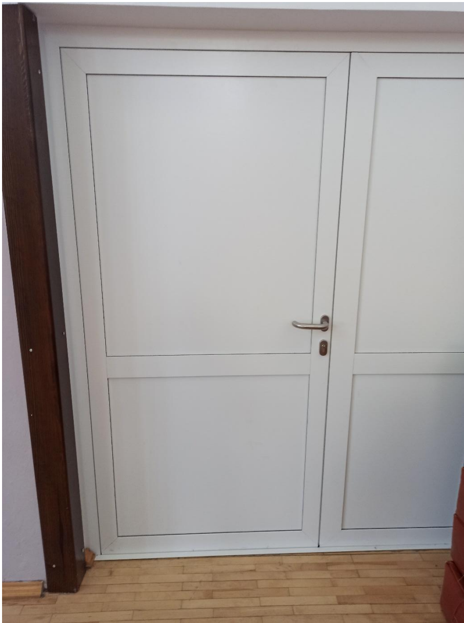
Wymiana drzwi w sali gimnastycznej
