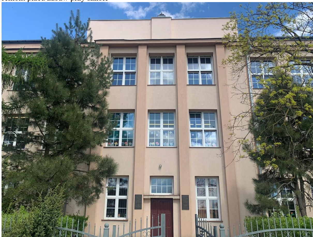
remont attyki w górnej części budynku w placówce
