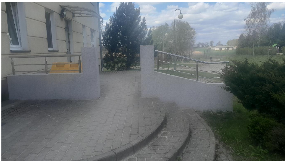
Zdjęcie 1-2 – remont murków zewnętrznych przy wejściu głównym
