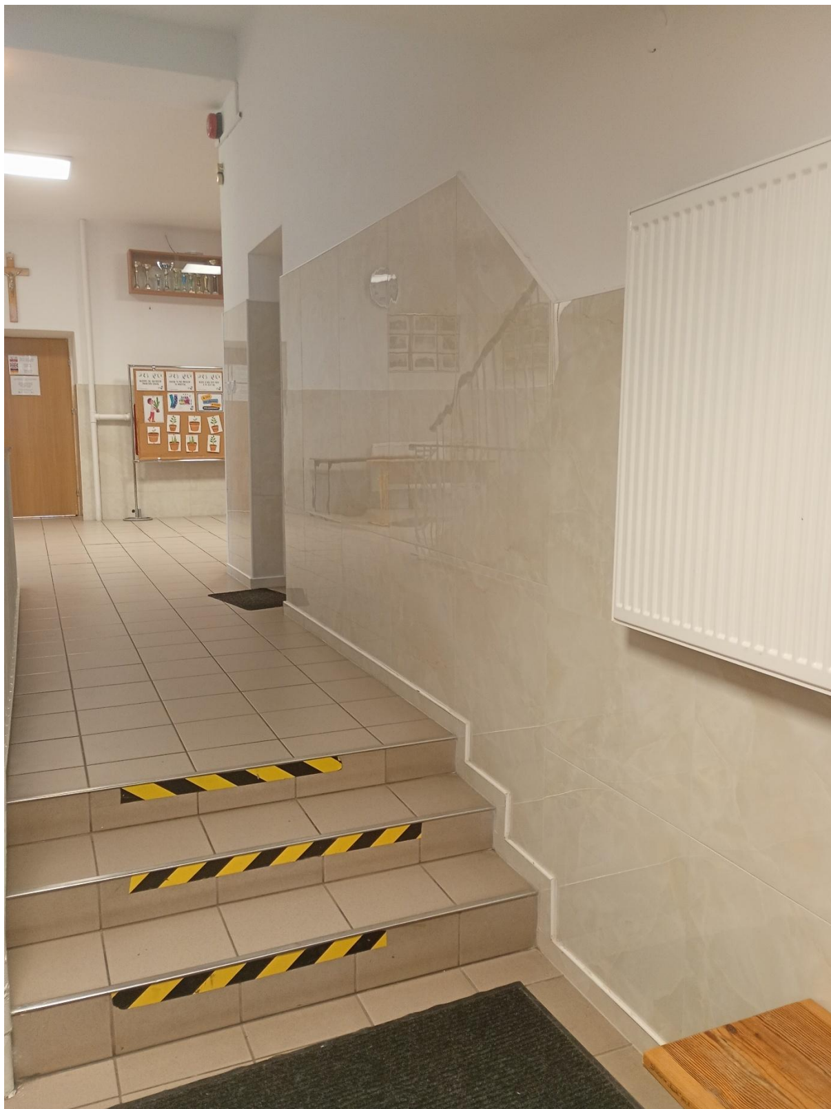
Remont korytarza na parterze szkoły
